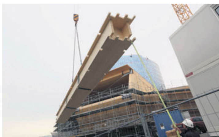
En haut: Thomas Büchi (à g.) et Rafael Villar (à d.) ont retenu leur souffle lorsqu'il a fallu retirer les béquilles soutenant le porte-à-faux. En bas: livraison du dernier caisson de bois. LUCIEN FORTUNATI
